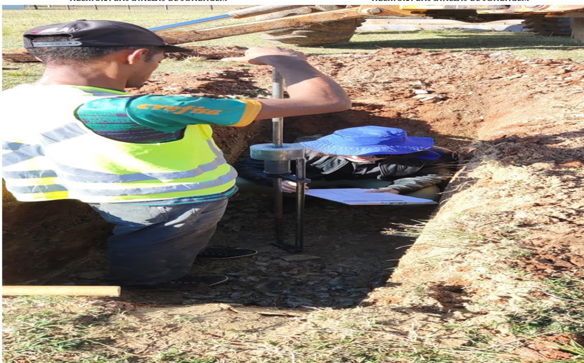
ABERTURA DAS JANELAS DE SONDAGEM
