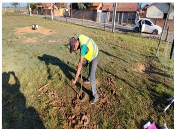
ABERTURA DAS JANELAS DE SONDAGEM
