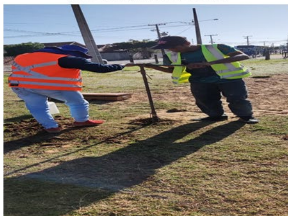
ABERTURA DAS JANELAS DE SONDAGEM
